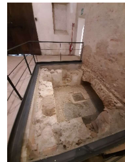
Monastero dell'Assunta di Cairate – stratificazione di pavimentazioni e fondazioni Photo credits: Giulia Pesaro
